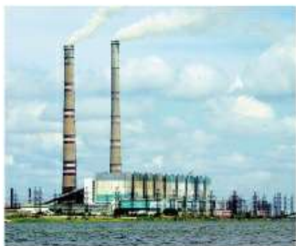
Рис. 234. Екибастузская ГРЭС-1 – крупнейшая электростанция Казахстана
