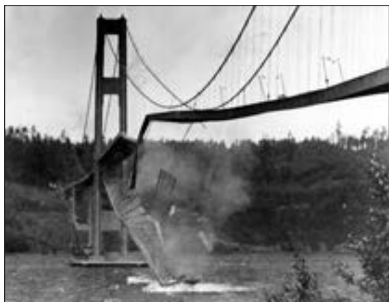
160-сурет. Америкадағы Такома көпірінің бұзылуы, 1940 жыл
